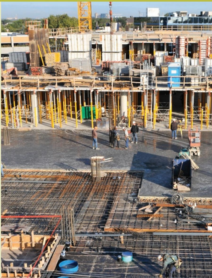
constitue un réel danger pour les travailleurs en pleine action. Pour que le chantier soit vraiment sûr, il ne s'agit pas de simplement déposer une feuille de contreplaqué sur les ouvertures. Ici, sur notre chantier, l'ouverture de la cage d'ascenseur a été solidement bouchée et délimitée par un ruban rouge.
